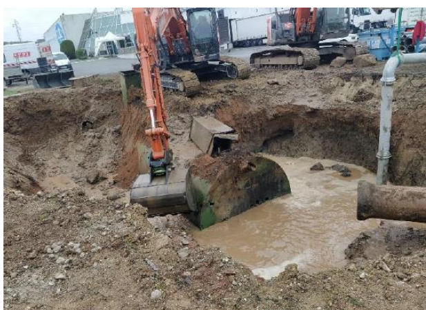
Suppression de la cuve métallique
