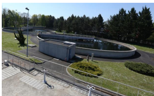
Clarificateurs UDEP Belfort
