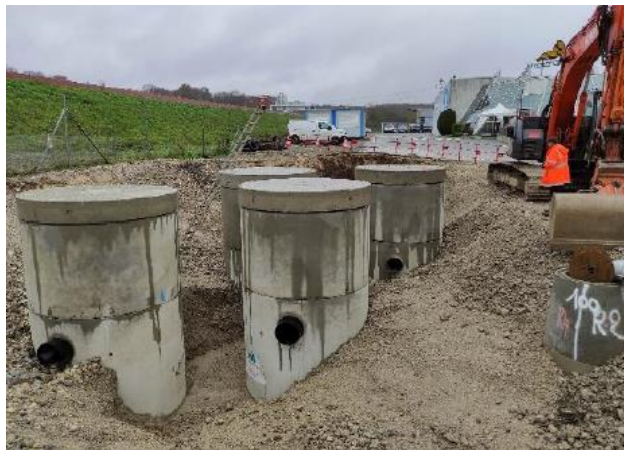
Mise en œuvre du décanteur lamellaire
