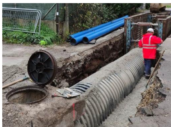
Pose d'un collecteur DN1000 rue des Lavandières
