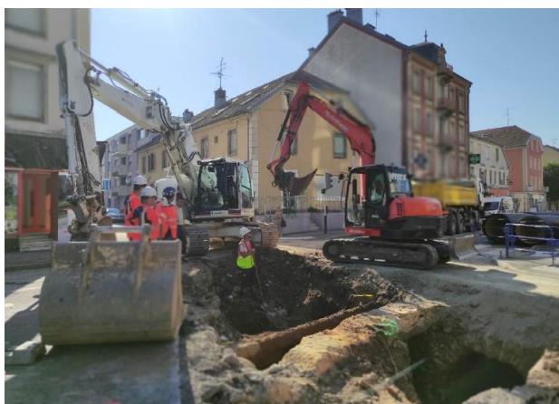
Réalisation d'un siphon avenue Jaurès
