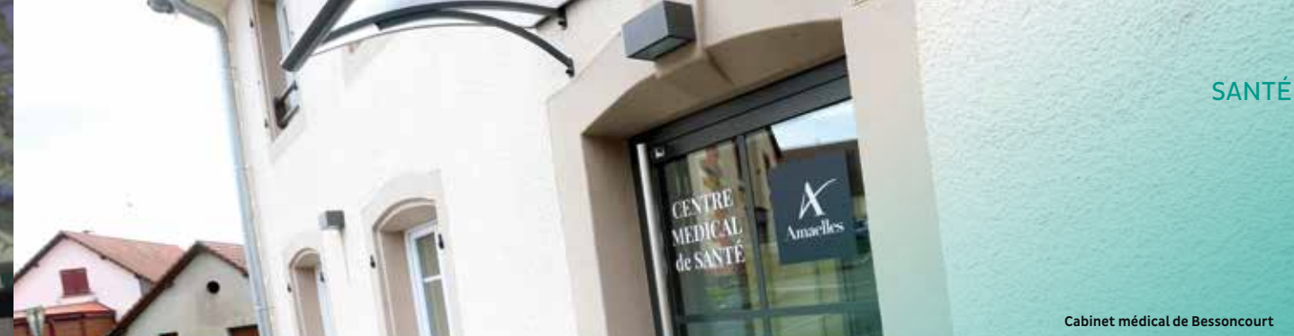
Cabinet médical de Bessoncourt
