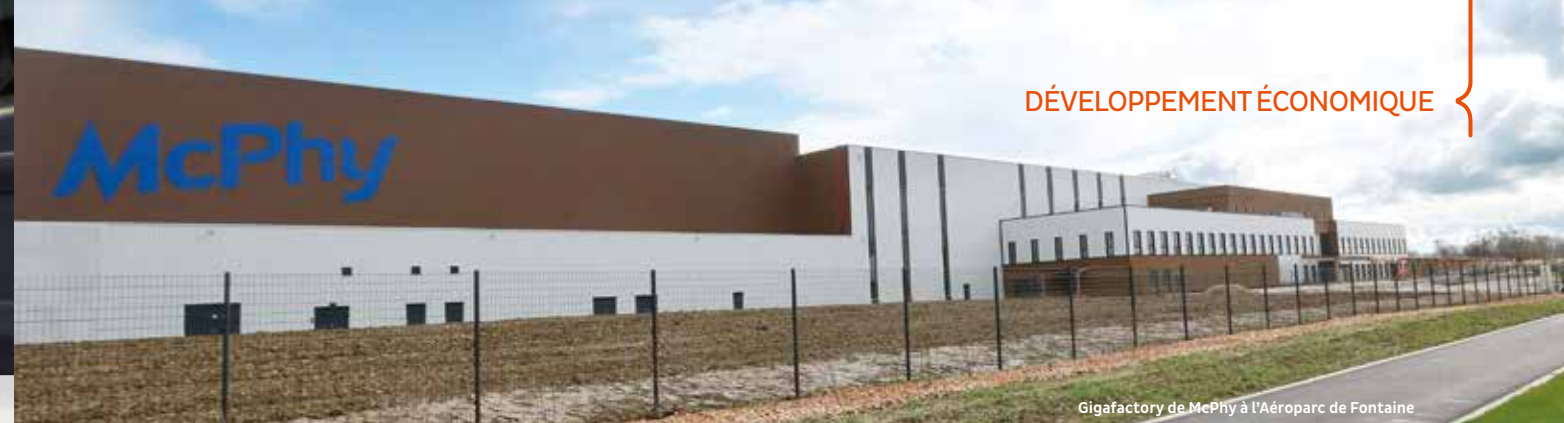
Gigafactory de McPhy à l'Aéroparc de Fontaine
