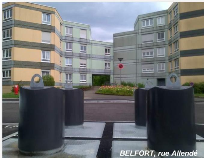
La société NVS Environnement a réalisé la prestation d'entretien des conteneurs enterrés (lavage, désinfection, graissage et remplacement de rivets) avec une campagne au printemps spécifique aux conteneurs d'ordures et une seconde à l'automne pour tous les conteneurs.
