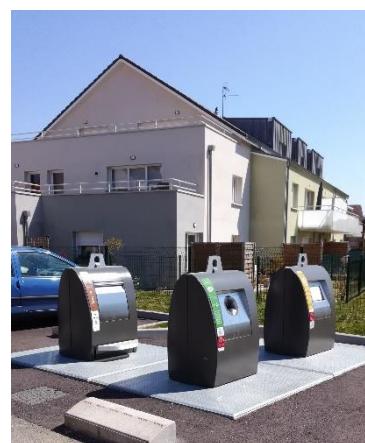
Conteneurs enterrés à Bauvilliers
