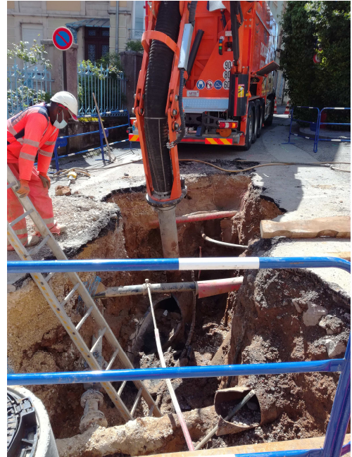
Travaux rue Fort Hatry
