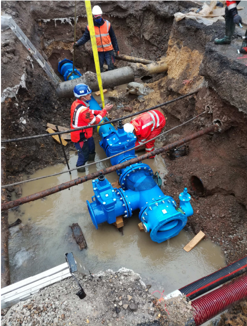
Travaux rue Maréchal Juin
