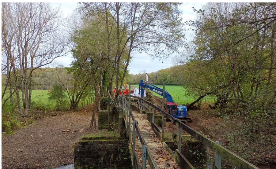
Lancement du chantier de réhabilitation de la passerelle des Sablettes, 2022
