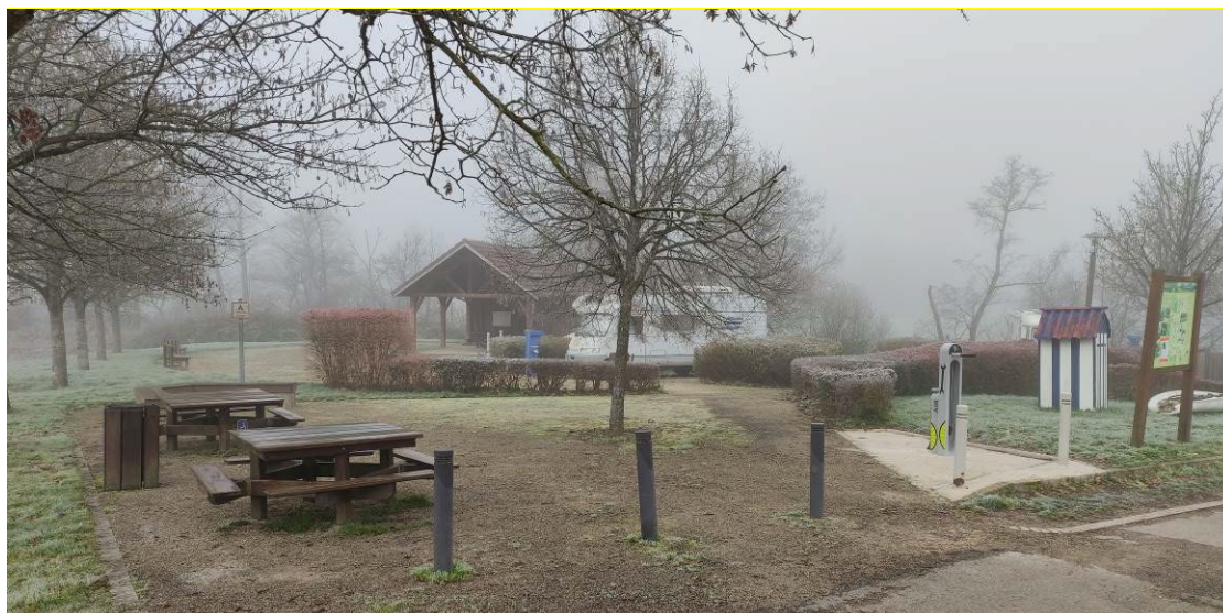
Aménagement de la halte fluviale de Montreux-Château, sur l'EuroVélo 6 Mise en place d'une borne multi-service pour les cyclistes (outils et gonflage), 2022
