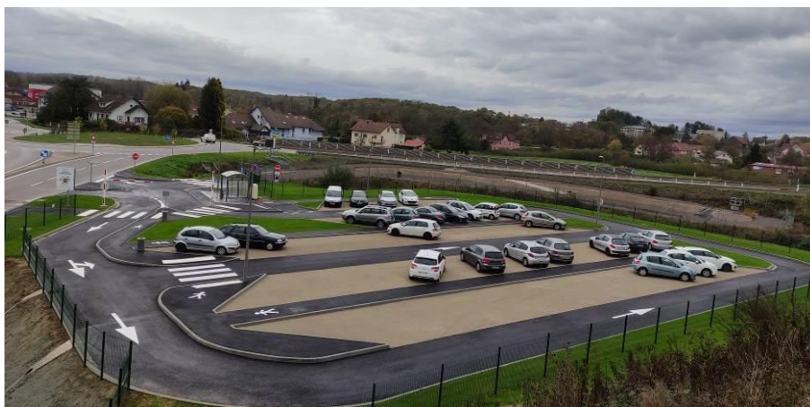
Parking de covoiturage, commune de Sévenans Réalisation Grand Belfort, 2022
