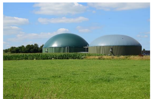
Usine de biogaz
