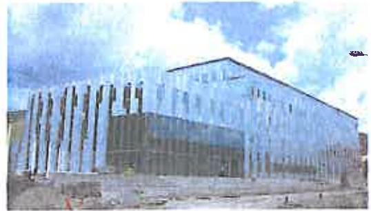
TECHN'HOM bâtiment 328 – Chantier du bâtiment ALSTOM POWER CENTRALES (août 2010)
