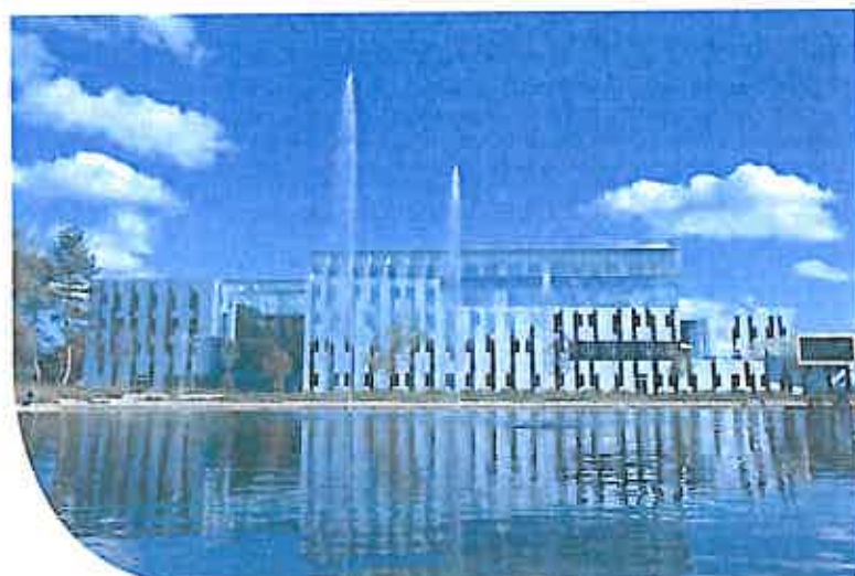
Techn'hom I, bâtiment à ossature acier, avec SEMPAT. Photographie de Gabriel Ferrer, www.360city.com
