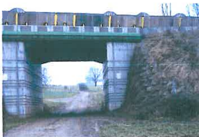
Passage agricole à Bourogne sous la RN 1019
