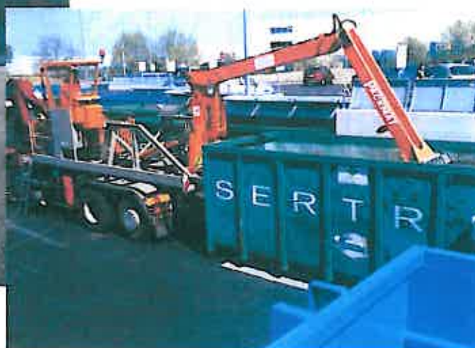
Utilisation du Packmat pour optimiser le remplissage des bennes
