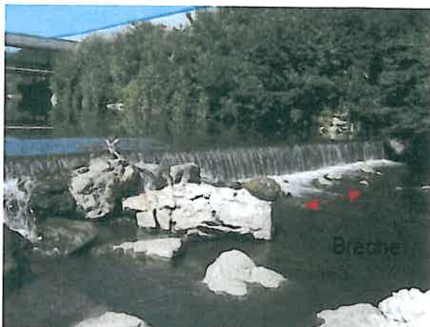
Seuil Station d'Épuration en 2012, avant renard hydraulique
