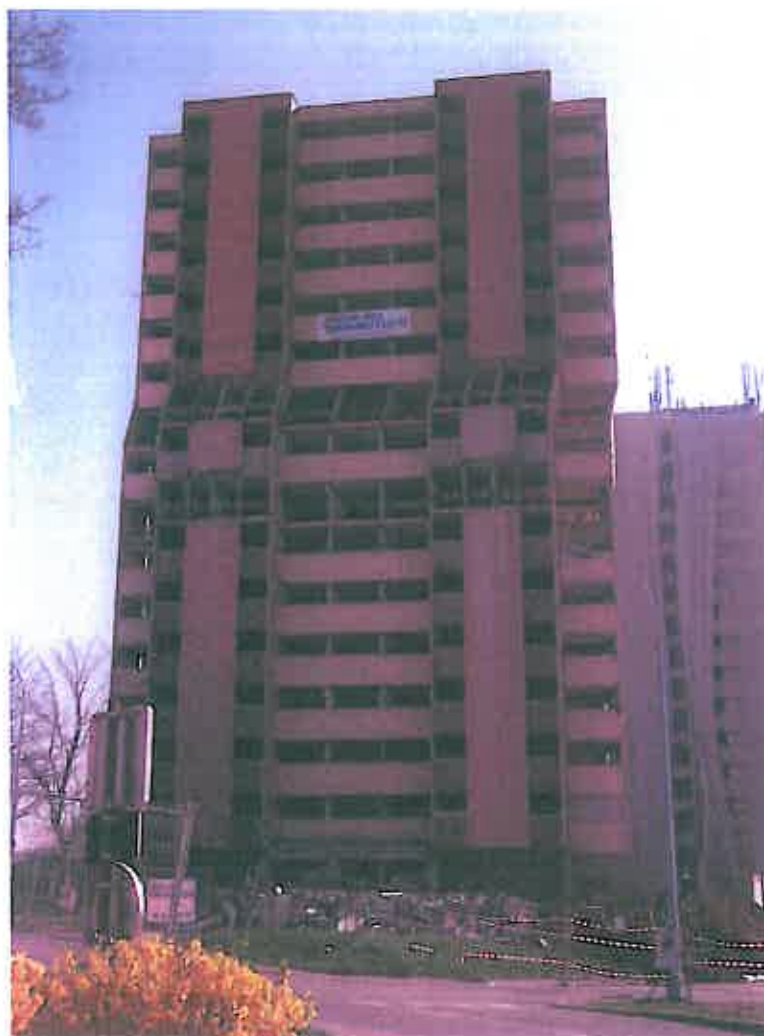
Belfort, démolition de la tour située au 1 rue d'Athènes
