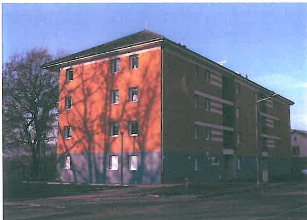
Offemont, construction neuve de 12 logements BBC, par Territoire habitat
