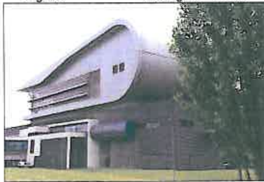
Figure 7 : déchargement de déchets à l'UIOM de Bourogne
