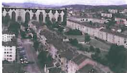
Espace Baudin avant sa recomposition urbaine DHRU - CAB
