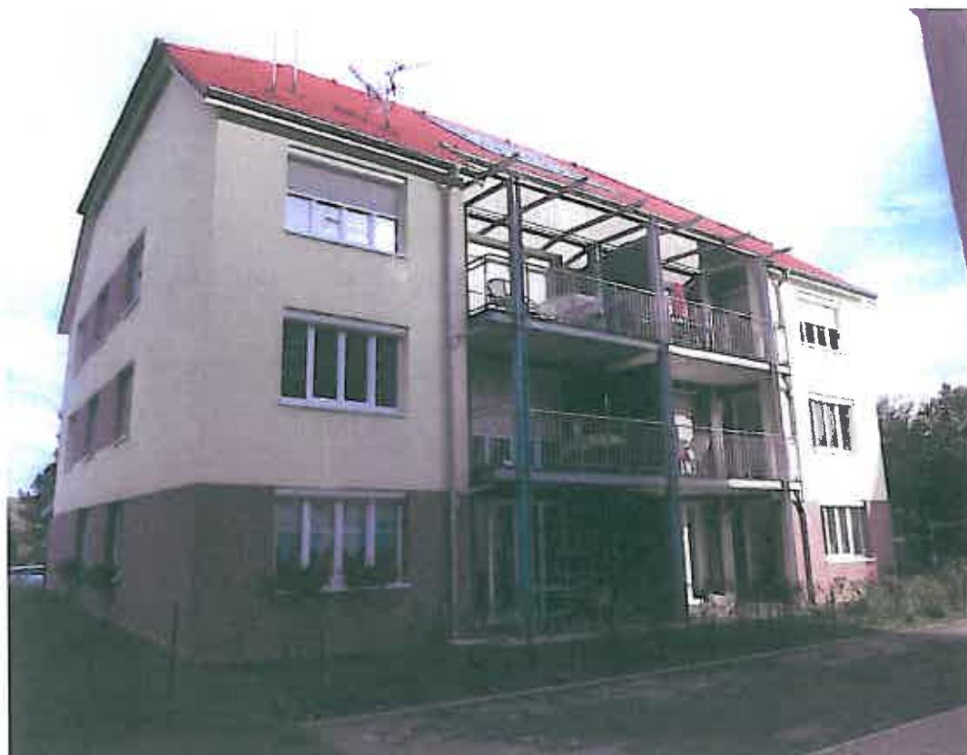
Roppe, création de 6 logements BBC par Territoire habitat
