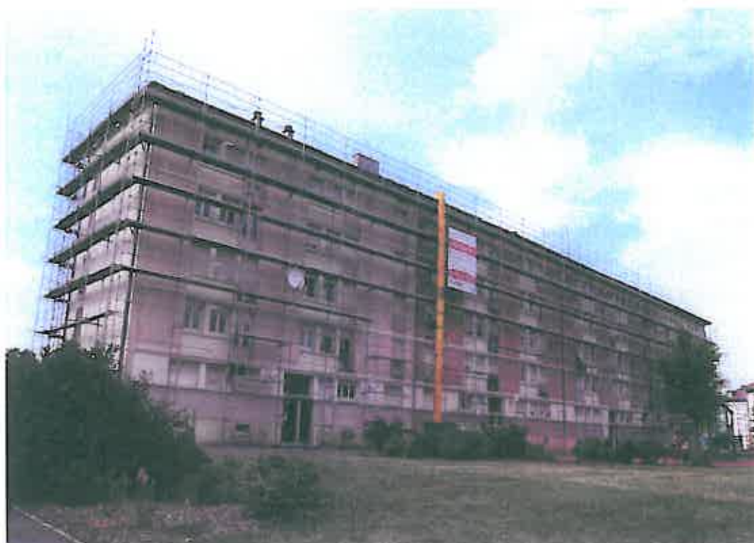
Belfort, réhabilitation de 68 logements, par Territoire habitat
