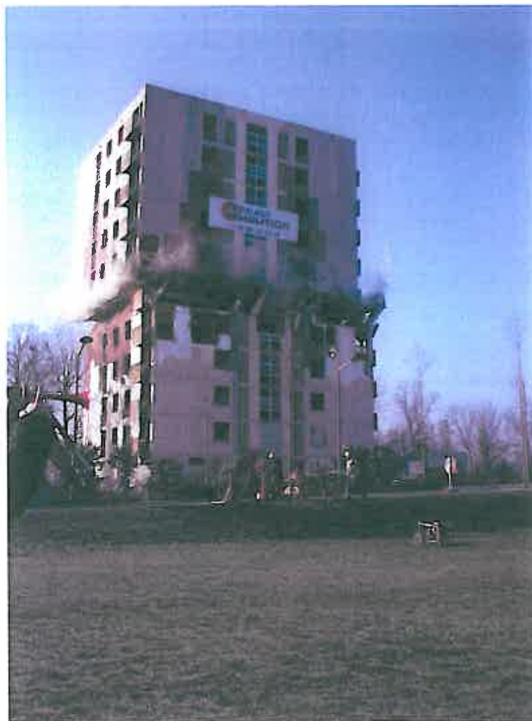
Offemont, démolition de la tour située au 26 rue Debrot
