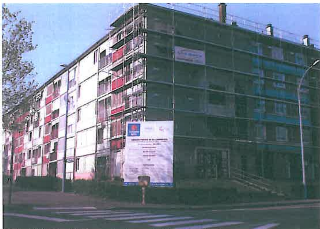
Belfort, réhabilitation de 90 logements sociaux rue de Vienne et rue de Sofia
