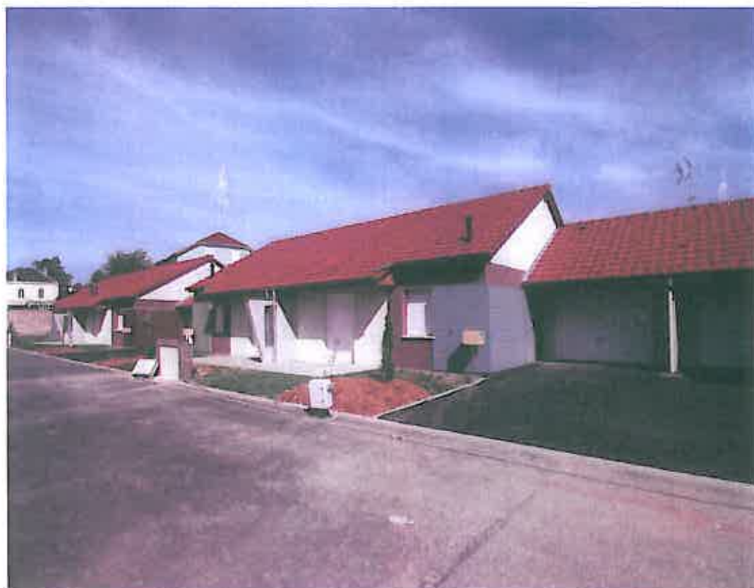
Châtenois-les-Forges, création de 8 pavillons locatifs destinés à des personnes âgées
