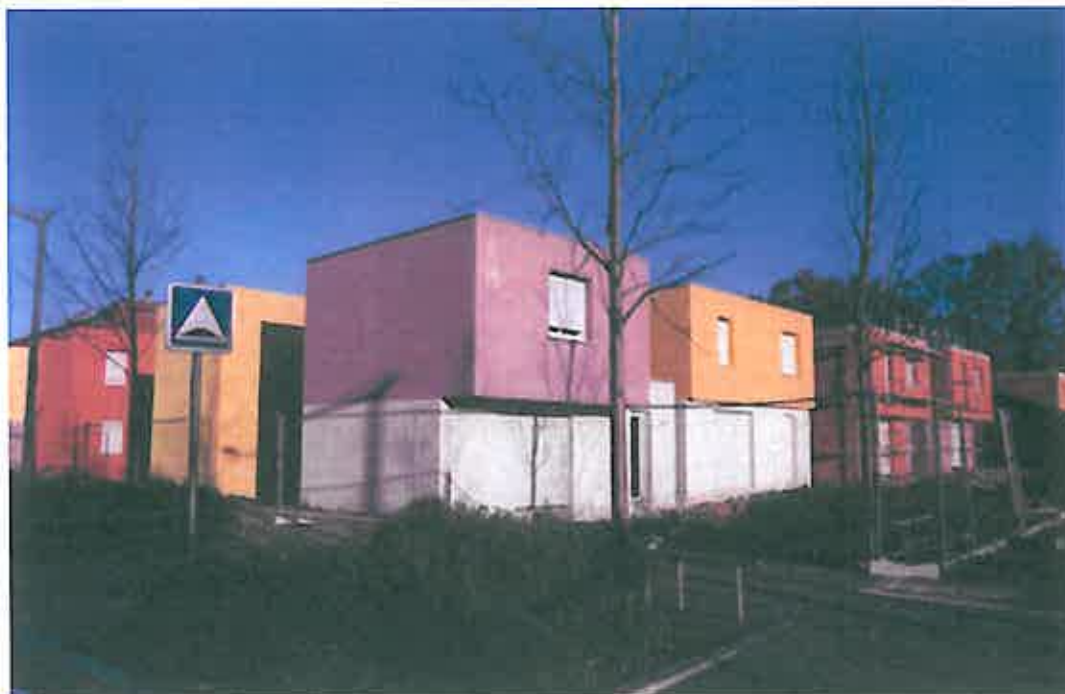
Offemont, construction de 3 pavillons en location-accession
