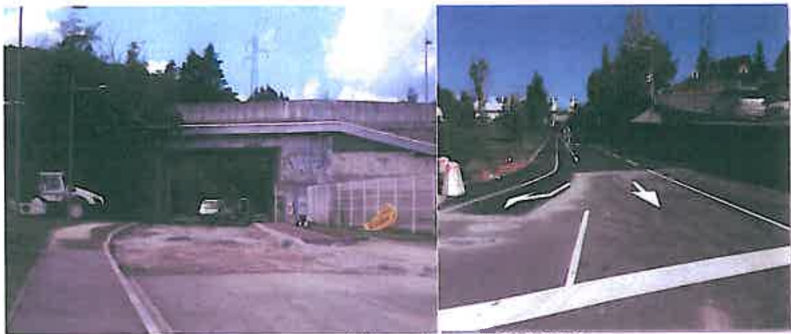
Travaux rue des Ailettes (photos CAB-SEMPAT)
