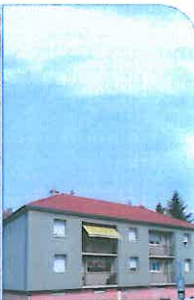
Réhabilitation de 68 logements Rue de la Paix
