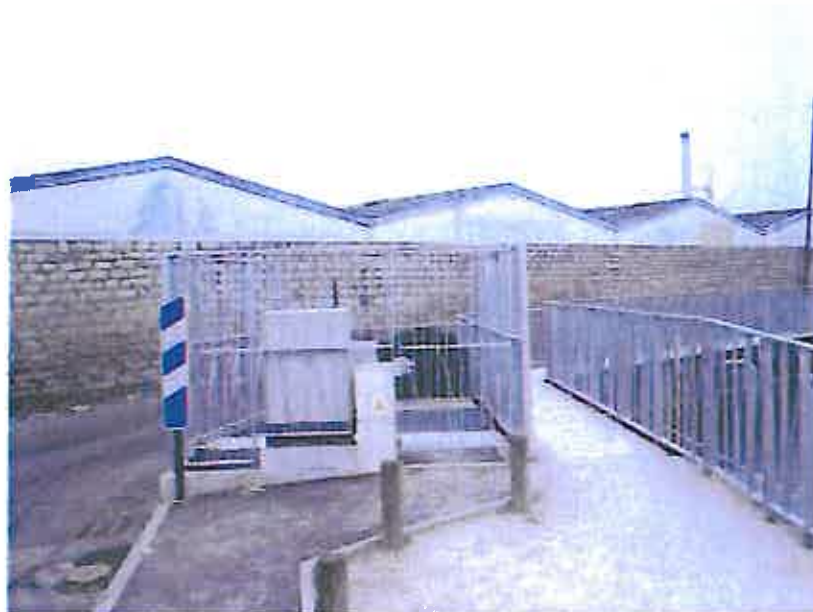
Plateforme de la chambre des vannes
