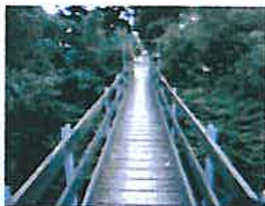
Passerelle des Sablettes
