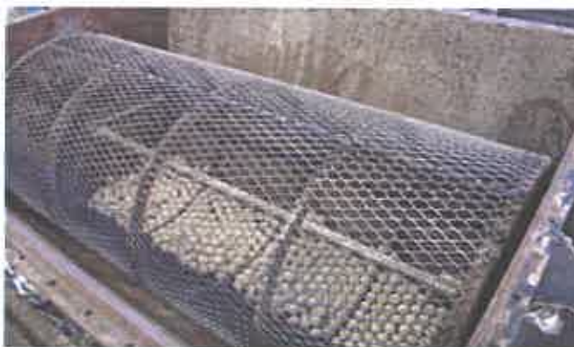
Réparation tambour coke de lignite
