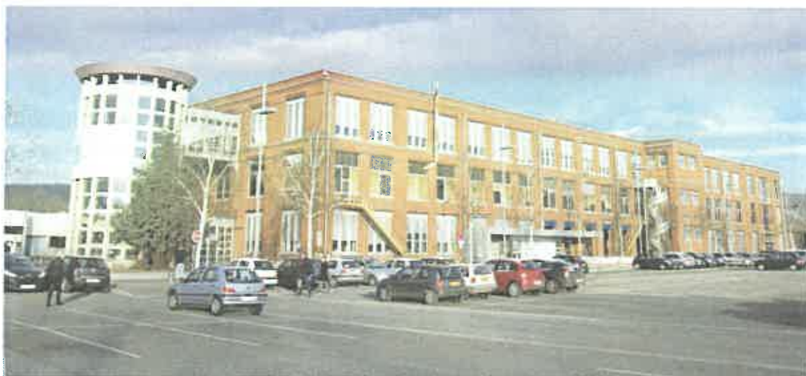
Figure 8 - Bâtiment 14 (Bât B UTBM)
