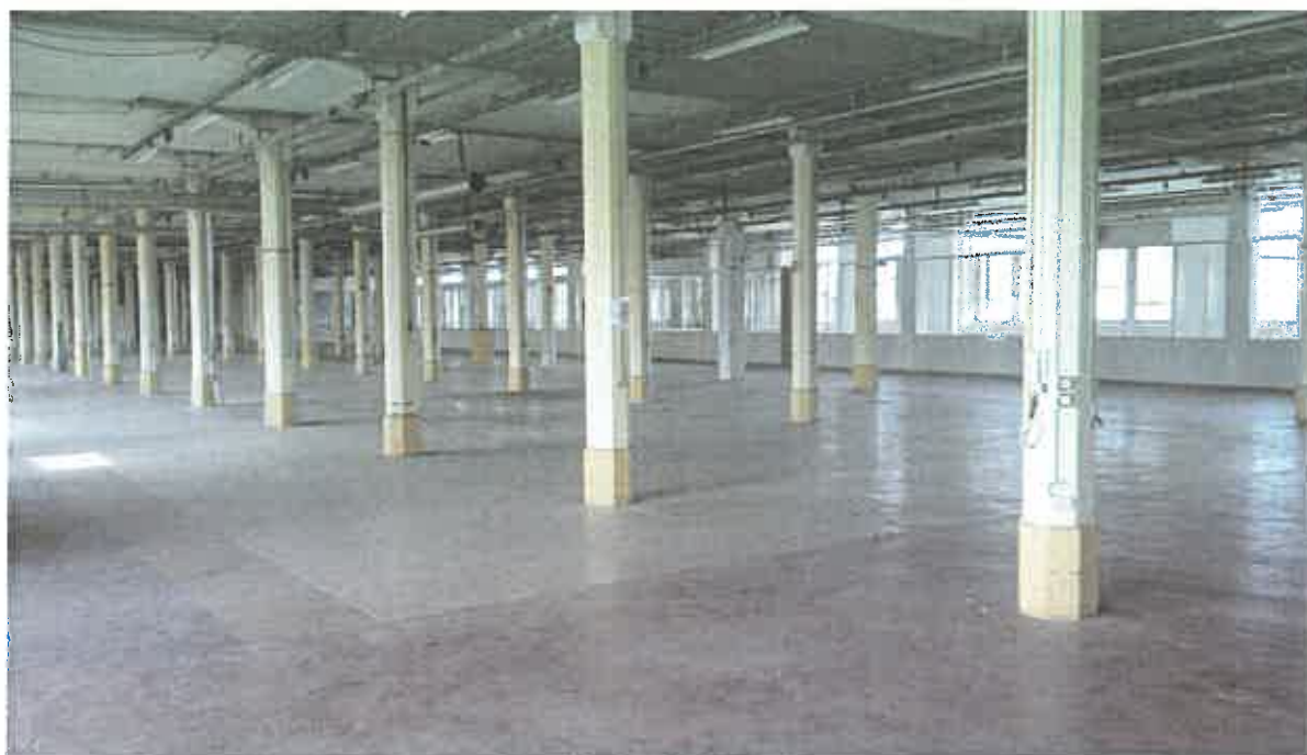
Figure 10 - Bat 14 Premier étage
