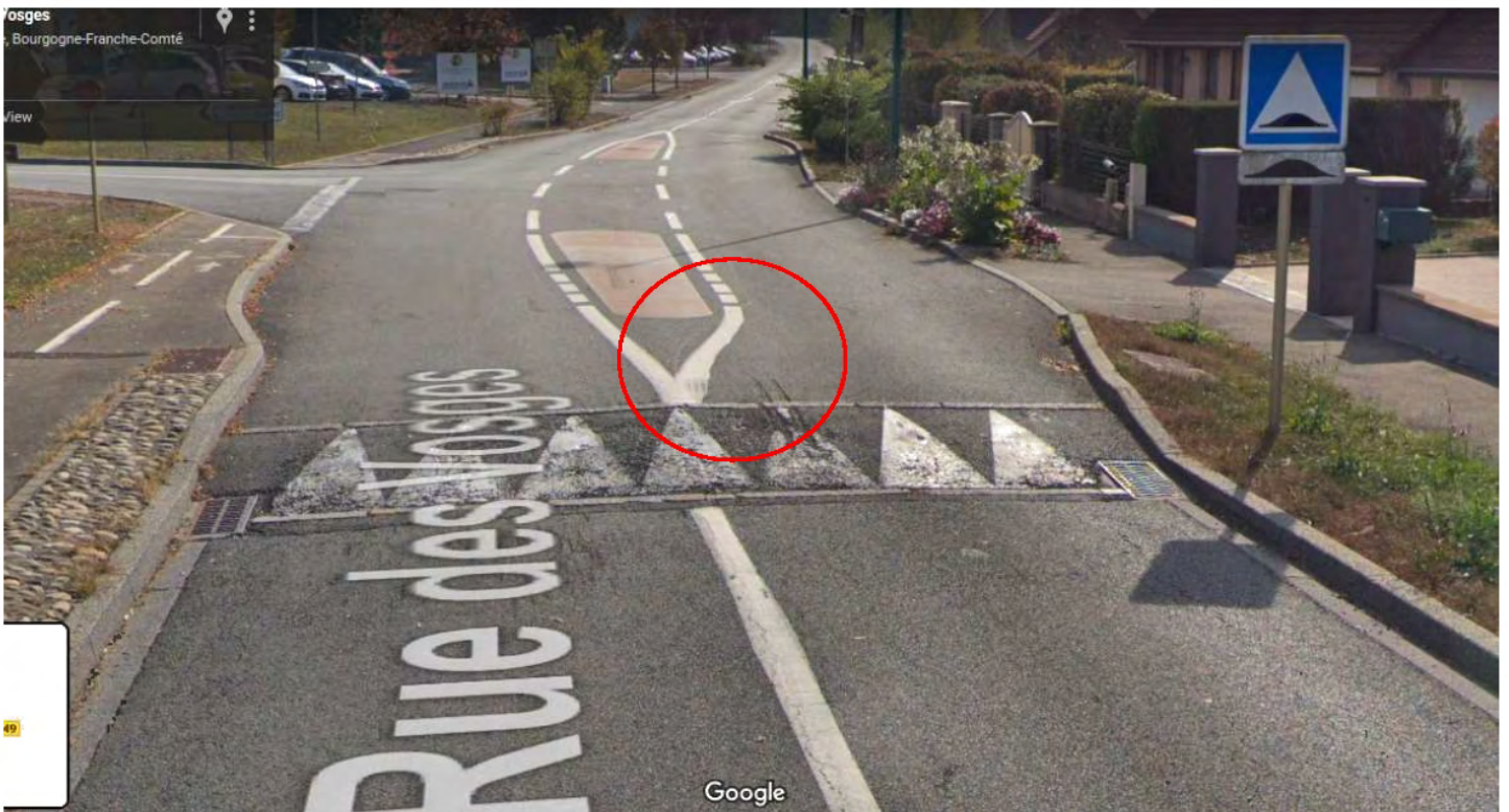
Photo 5 – Dos d'âne à la sortie de Fousse-magne, en venant de l'Aéroparc
