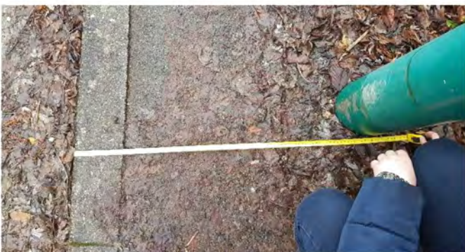
Photo 3 – Largeur de trottoir de 0,75 m au niveau du n°5 rue des Vosges
