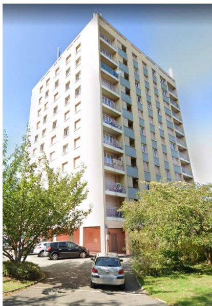
Photo de l'existant avant travaux
